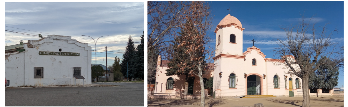
▲ Imagen 13. Algunas de las estructuras que perduran del primer asentamiento de YPF en el Barrio 1, y conforman parte del patrimonio edilicio histórico de la localidad, el cine (Izq.) y la capilla (der.). Fuente: ONU_Habitat, 2023
