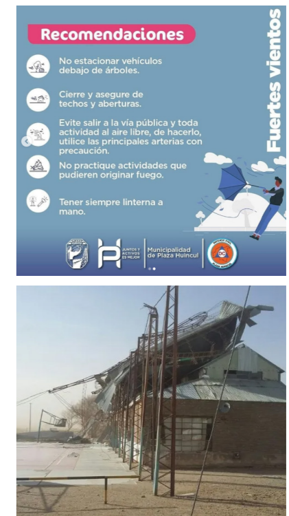
▲ Imagen 9. (arriba) Recomendaciones de Defensa Civil ante alertas meteorológicas por fuertes vientos. Fuente: Prensa Municipalidad de Plaza Huinul, 26-04-2022. (abajo) Voladura de techos en Escuela de Policía. Fuente: La Mañana de Neuquén, 23-08-2017.
