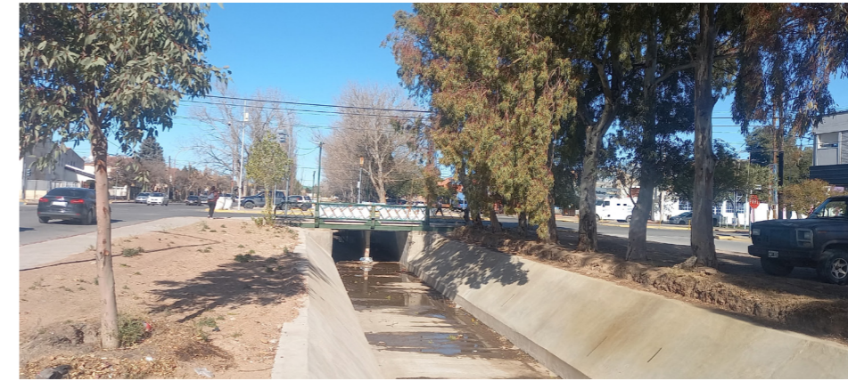
▲ Imagen 6. Vista de canal colector pluvial ubicado paralelo a ruta 22. Fuente: ONU-Habitat, 2023.
