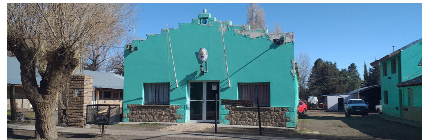
◀ Imagen 18. Edificio municipal El Huecú. Fuente: ONU-Habitat, 2023.
