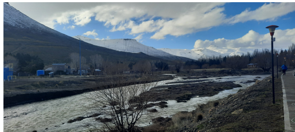
▲ Imagen 3. Vista hacia aguas arriba del puente. Fuente: ONU-Habitat, 2023.
