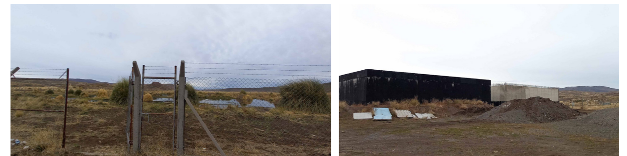
▲ Imagen 11. Primer sitio de tratamiento de líquidos cloacales. Fuente: ONU-Habitat, 2023. Imagen 12. Nueva planta de tratamiento de líquidos cloacales en construcción de El Hucú. Fuente: ONU-Habitat, 2023.
